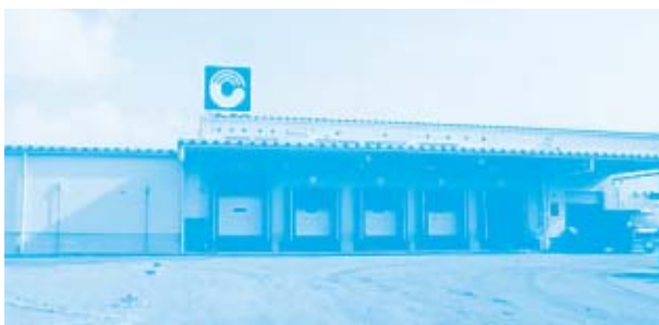
建物西側に増設された入荷口。品質を保つための工夫がされています。左側は増設された冷凍・冷蔵庫。
